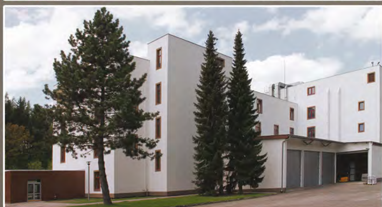
Hlavní provozovna Dřevotvar po rekonstrukci.
