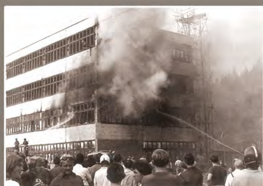
Požár v budovaném areálu závodu v Jablonném 5.8.1971
